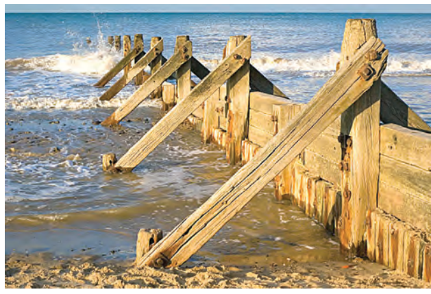
نصب حفاظ عمودی
