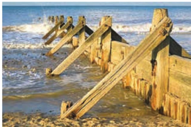
نصب حفاظ عمودی
