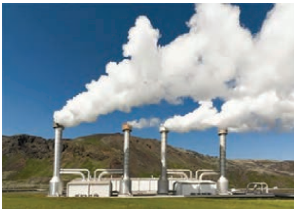
شکل ۹-۴. نیروگاه زمین گرمایی مشکین شهر - اردبیل
