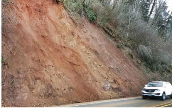
زیربُری دامنه برای ساخت جاده و وقوع لغزش
