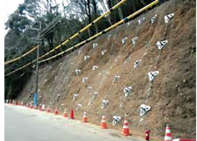
پایدار سازی دامنه به روش شمع کوبی با استفاده از میل‌گرد فولادی، بستن مهره و تزریق سیمان
