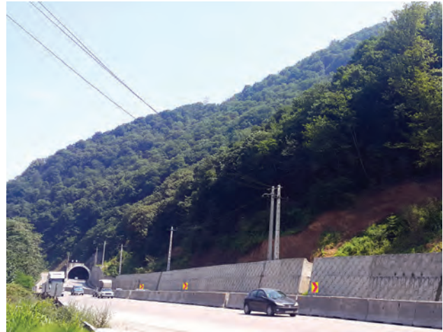
نصب حفاظ بتونی - جاده قائم‌شهر
