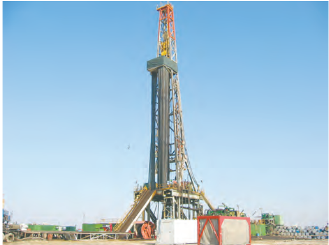
شکل ۱۰- دکل حفاری چاه‌های اکتشافی نفت و گاز
